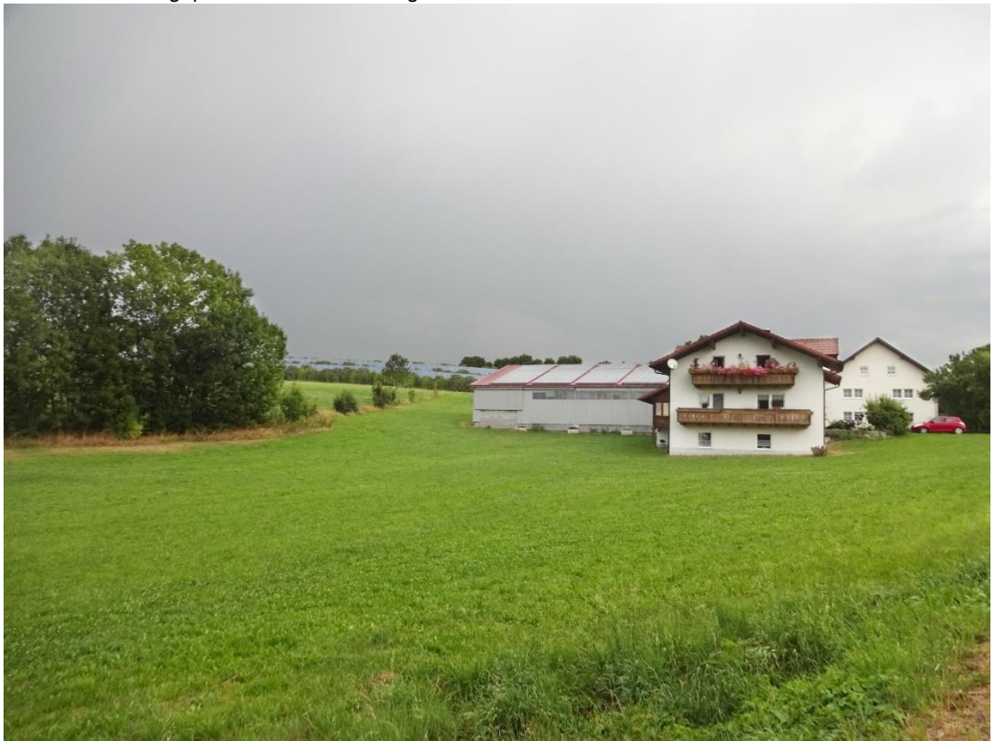
Blick von Süden (südlich Judenhof 30) auf die Anlage. Durch mehrere Hecken im steilen Hangbereich ist die Anlage weitgehend abgeschirmt, im Hinblick auf die Fernwirkung (z.B von Südwesten bei Niedernberg) ist die abschirmende Wirkung der Hecken, von höheren Standorten aus auf die geplante Anlage betrachtet, wirksamer.
