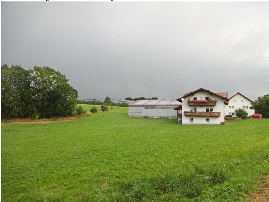
Blick von Süden (südlich Judenhof 30) auf die Anlage. Durch mehrere Hecken im steilen Hangbereich ist die Anlage weitgehend abgeschildert, im Hinblick auf die Fernwirkung (z.B von Südwesten bei Niedernberg) ist die abschirmende Wirkung der Hecken, von höheren Standorten aus auf die geplante Anlage betrachtet, wirksamer.
